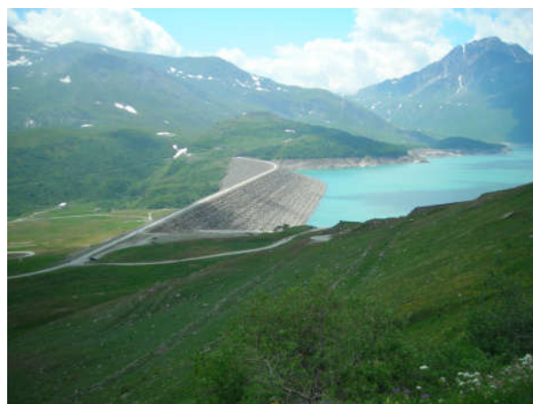
Le barrage-poids du Mont-Cenis
